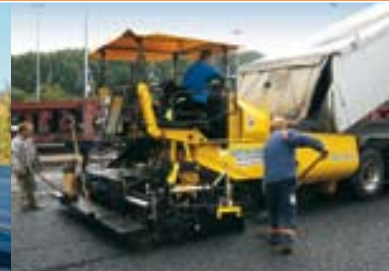
Demag DF-65 beim Tragschichteinbau
