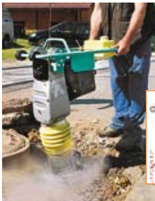
Bewegungsablauf von Vibrationsstampfern.
