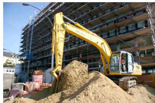
Sorgte für Nachschub: Der New Holland E 215 B aus dem HKL MIETPARK beförderte über 5.000 m 3 Füllmaterial in den Schacht.
