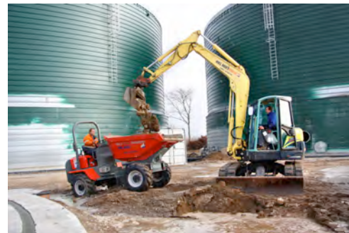
HKL Mietmaschinen im Einsatz beim Bau der größten Rüben-Biogasanlage Europas im schleswig-holsteinischen Schuby.
