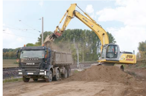
26 Tonnen-Raupenbagger aus dem HKL MIETPARK beim Befüllen eines Kippers auf der Gleisbaustelle der DB Netz AG in Niedersachsen.
