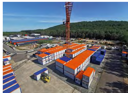
Hier finden sich über 500 Einheiten jeder Art und Ausstattung – vom Standardcontainer bis zur kompletten Anlage.
