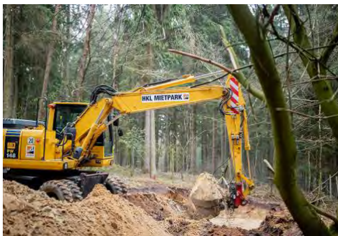
Baumaschinen aus dem HKL MIETPARK im Einsatz am Wildpark Lüneburger Heide. (Bild: Adrian Fohl)
