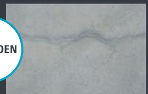
**Ohne Fugen:** Der Beton bekommt erhebliche, unkontrollierte Risse.
