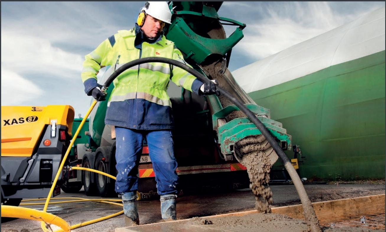
Ein Vorteil der Pneumatik ist, dass die Druckluft die Temperatur in der Rüttelflasche niedrig hält.
