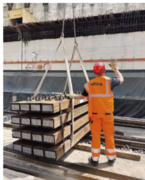
Auf der Tunnelsohle angekommen, werden die Gleisschwellen entgegengenommen, danach per Zweibegebagger von Willke ins Tunnelinnere befördert.
