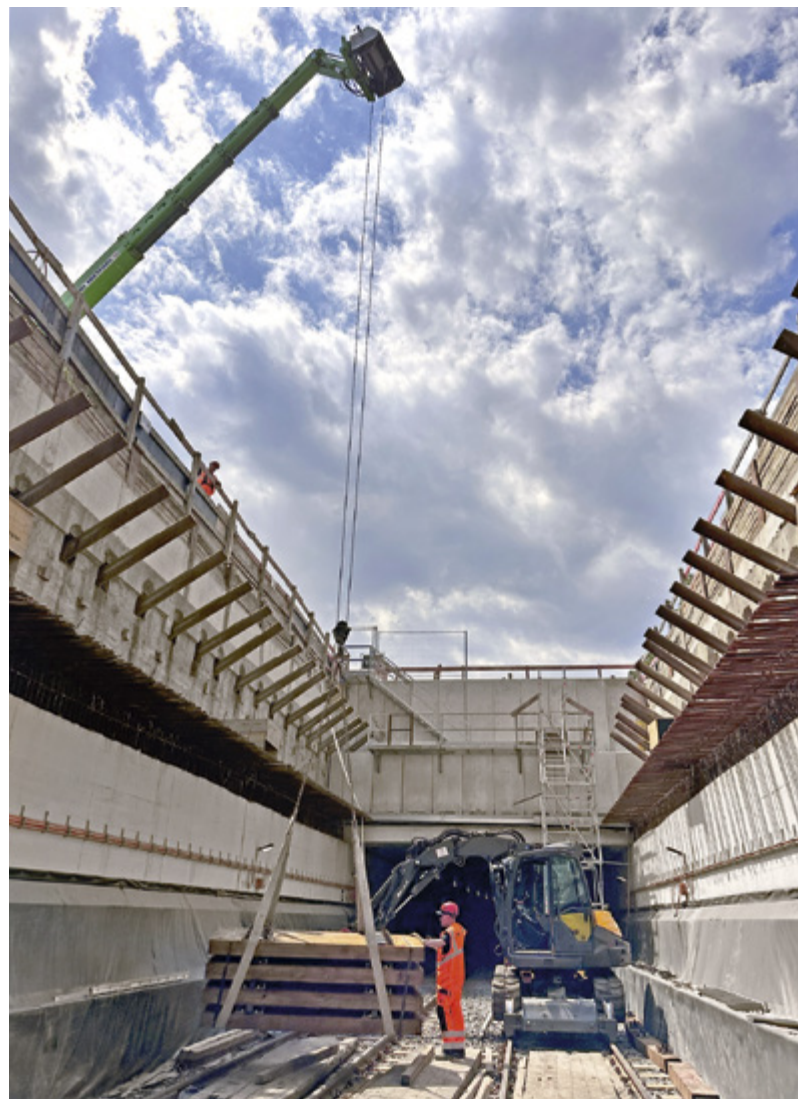
Auf der Tunnelsohle angekommen, werden die Gleisschwellen entgegengenommen, danach per Zweibegebagger von Willke ins Tunnelinnere befördert.
