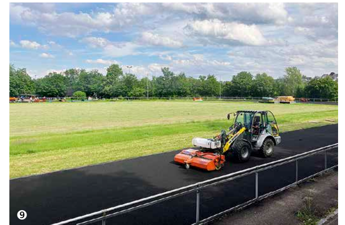
9 Sportlich: Ein Radlader von HKL legt eine Tartanbahn in Köln an.
