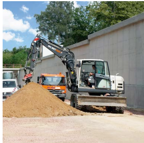
HKL Mietmaschinen im Einsatz beim Ringschluss Ost im Raum Aschaffenburg.
