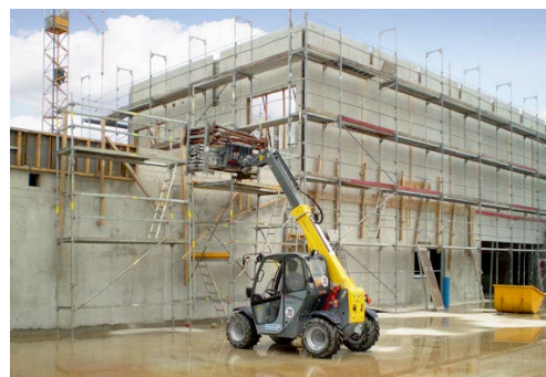
Der vielseitige Teleskoplader aus dem HKL MIETPARK bewährt sich beim Bau des Lippstadter Fachmarktzentrums „Südertor Ost“.
