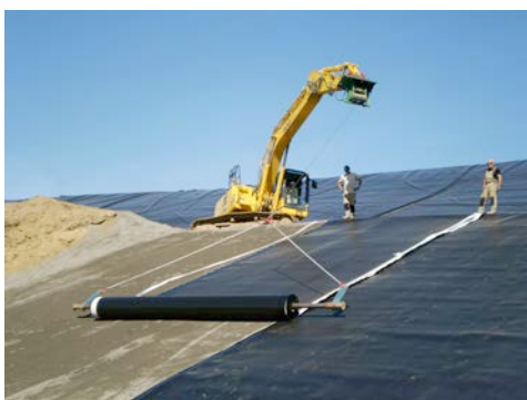
Umgebauter HKL Mietbagger mit Spezialseilwinde im Einsatz bei der Oberflächenabdichtung der Hausmülldeponie Berg in Rheinland-Pfalz.
