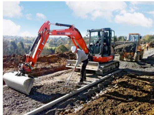
Kubota Kurzheckbagger U 55-4 aus dem HKL MIETPARK im Einsatz an der A 8 bei Pforzheim.
