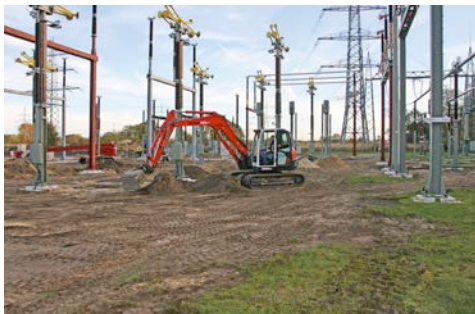
Bagger aus dem HKL MIETPARK im Einsatz bei der Erweiterung eines Umspannwerks in Gütersloh.
