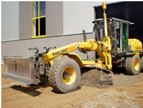
HKL Grader bei der Bodenplanung in der großen Lagerhalle.
