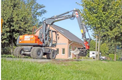
Feinfühliges Arbeiten bei gleichzeitigem Fahren: Bankett-Erneuerung mit dem Atlas 160 W aus dem HKL MIETPARK.
