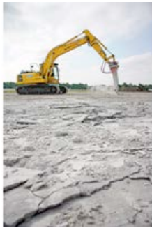
HKL-Mietmaschine mit speziell ausgestattetem Stemmhammer im hohen Einsatz am Hamburger Flughafen.
