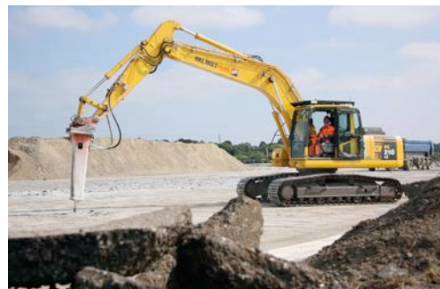
Mit Stemmhammer bearbeitet der Raupenbagger aus dem HKL MIETPARK die enorme Fläche von 14.000 Quadratmetern Landebahn am Hamburger Flughafen.
