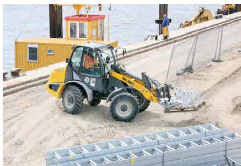
Radlader von HKL als Materialbeförderer – hier beim Transport von Geländer-Bügeln.
