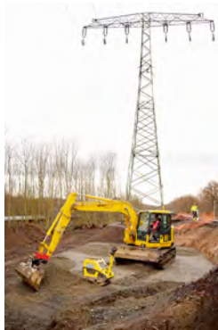
Kettenbagger und Rüttelplatte aus dem HKL MIETPARK unterstützen Fundamentarbeiten im Freileitungsbau zwischen Espenhain und Rötha.
