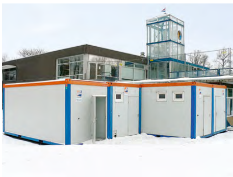
Speziell konzipierte Container-Anlagen begleiten den Neubau des Allwetter- und Freibades Okeräue in Wolfenbüttel.
